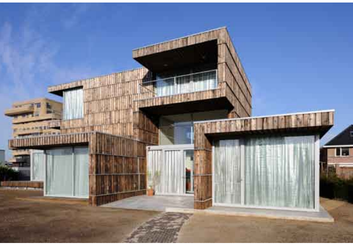
Enschede. Villa Welpeloo (2009), Einfamilienhaus aus 60% recycelten Baustoffen, Architektur: 2012Architecten, Rotterdam Foto: Allard van der Hoek/Forum Ludwig
